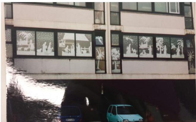
Un'immagine di allora della facciata della scuola.
